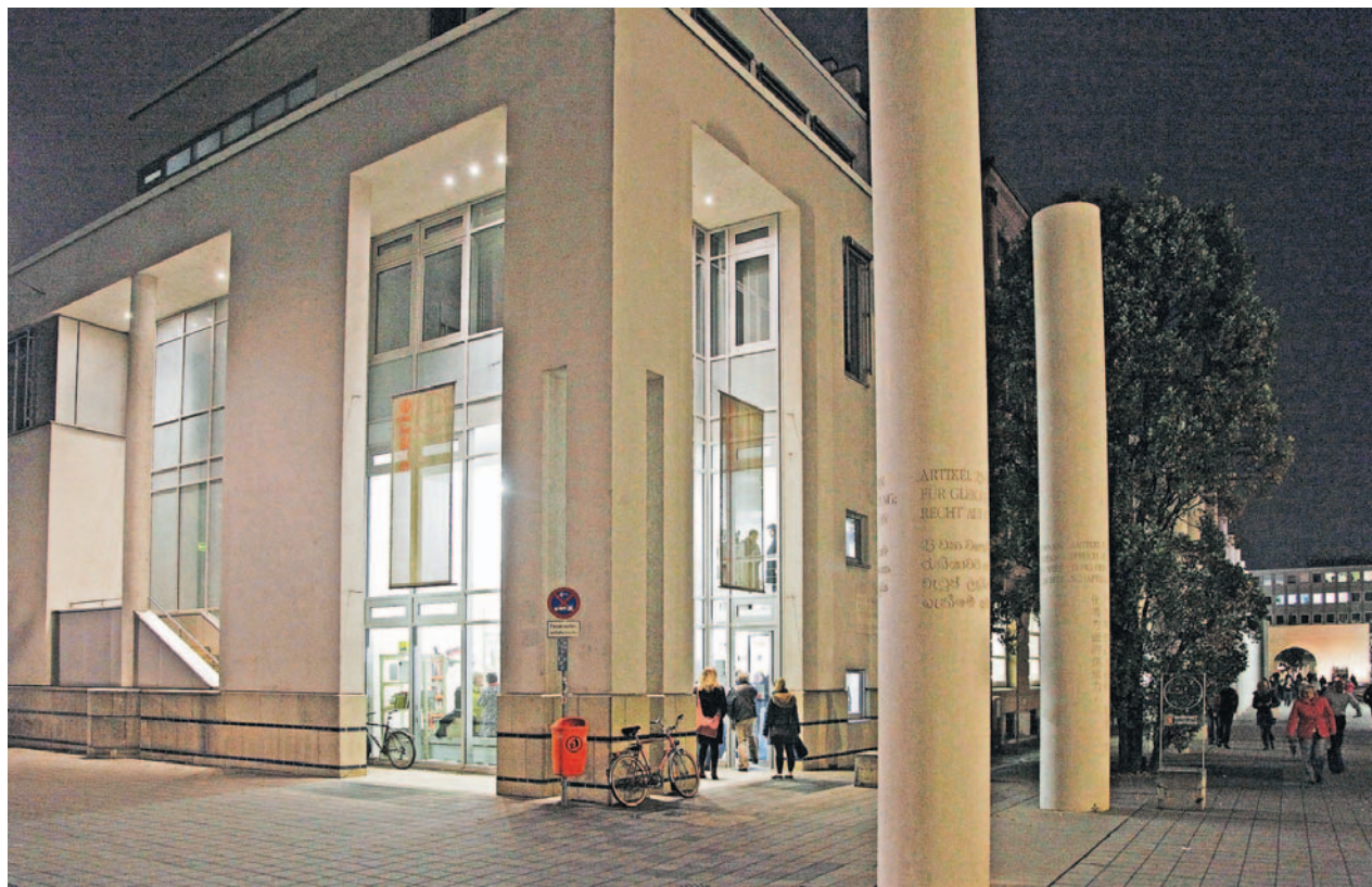
In prominenter Lage, direkt am Germanischen Nationalmuseum, bietet die Kreis-Galerie in der Kartäusergasse der traditionsreichen gleichnamigen Künstlervereinigung seit dem Jahr 2000 ein festes Domizil. Der Blick durch die Glasfassaden macht oft auch zufällige Passanten auf das abwechslungsreiche Kunstgeschehen im Inneren neugierig.
